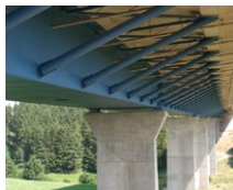
Steinbachtal Brücke (DE)
