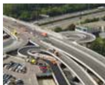
Brücke Glattzentrum (CH)
