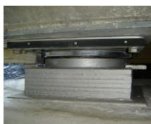
Kalottenlager
