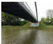
MLK Brücke Nr. 5a (DE)
