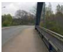
MLK Brücke Nr. 17 (DE)
