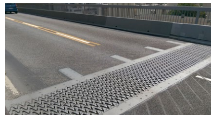
Neue wasserdichte lärmgedimmte Lamellendehnfuge mit Quick-Ex-System
