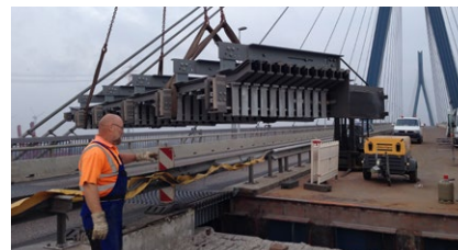
Einheben der neuen wasserdichten lärmgedimmten Lamellendehnfugen
